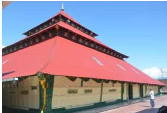
Fig.2. Masjid Agung Pondok Tinggi
